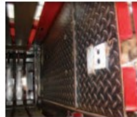
Sonde montée dans le canal de la presse
